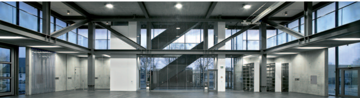
Bild 34: Der flexibel gestaltete Produktionsbereich des Montage- und Verwaltungsgebäudes ESTA in Senden erlaubt eine schnelle und kostengünstige Anpassung bei Produktwechsel und garantiert eine hohe Drittverwendungsfähigkeit. (Architekt: Gerken Architekten + Ingenieure, Ulm)
