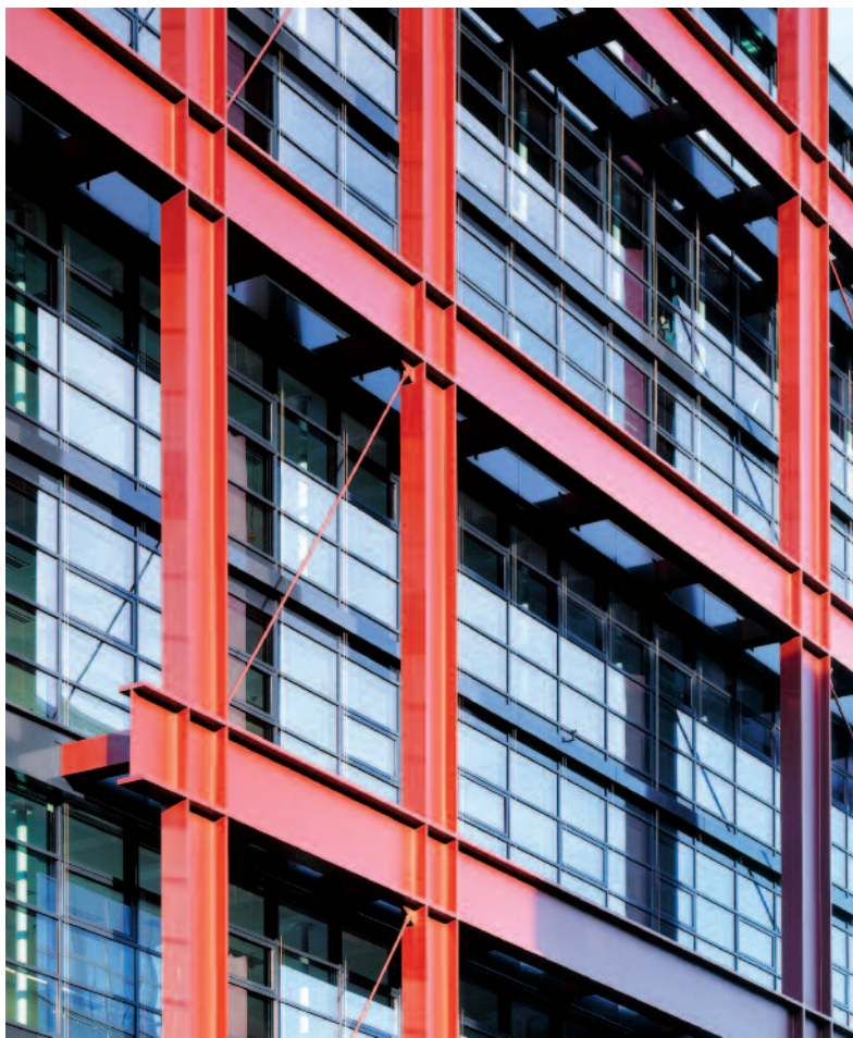
Bild 67: Bürogebäude am Sandtorkai in Hamburg: Durch die Trennung von Tragkonstruktion und nichttragender Außenwand konnte die erforderliche Feuerwiderstandsdauer der Stahlbauteile reduziert werden. (Architekt: Bothe Richter Teherani, Hamburg)
