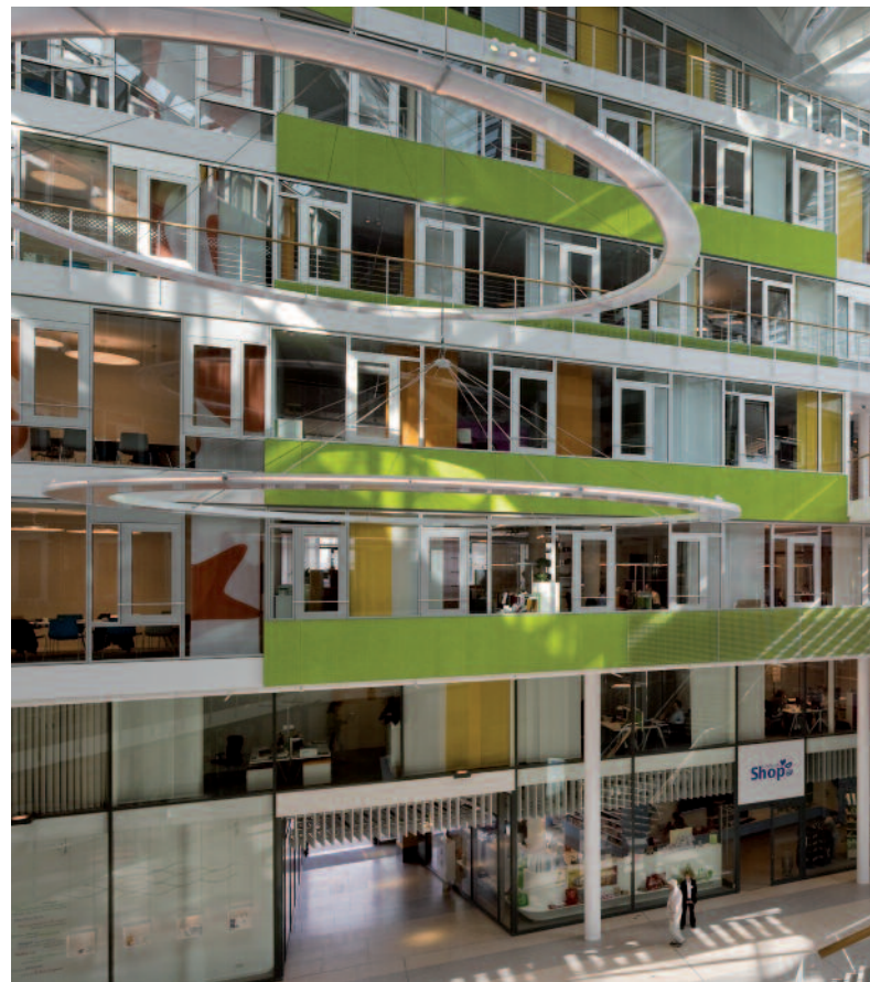
Bild 5: Der Atriumsbereich der Unilever-Zentrale in Hamburg ist öffentlich zugänglich und bietet Platz für Läden und Restaurants. (Architekt: Behnisch Architekten, Stuttgart)
