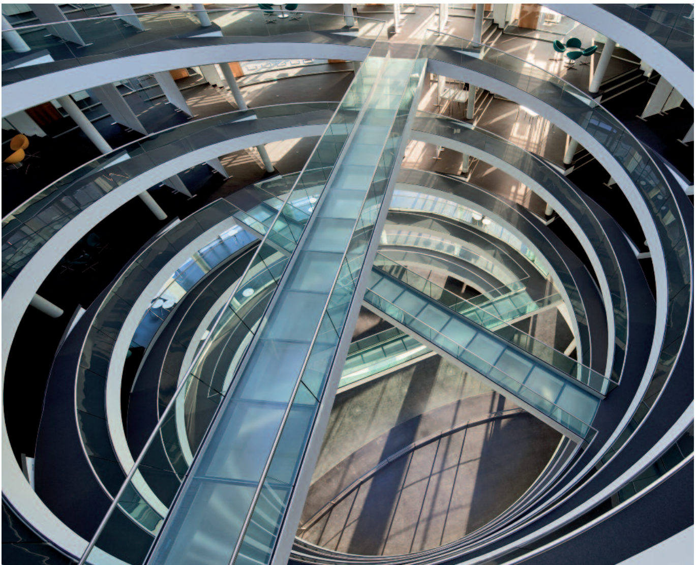
Bild 20: Advance Training Centre Heidelberg: Über die spiralförmige Rampe wird das Gebäude barrierefrei erschlossen. (Architekt: Bernhardt + Partner, Darmstadt)
