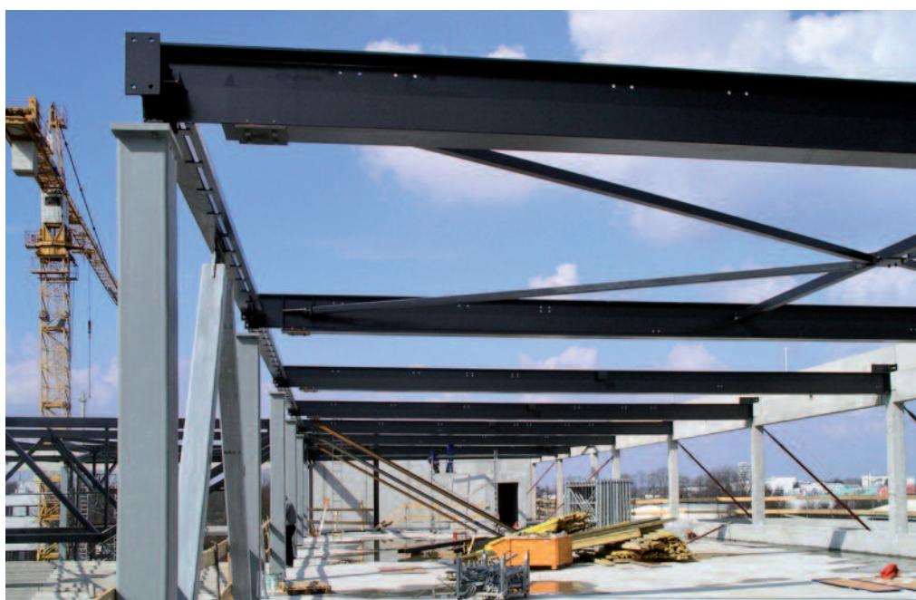
Bild 54: Stahlbaumontage: schnell und präzise
