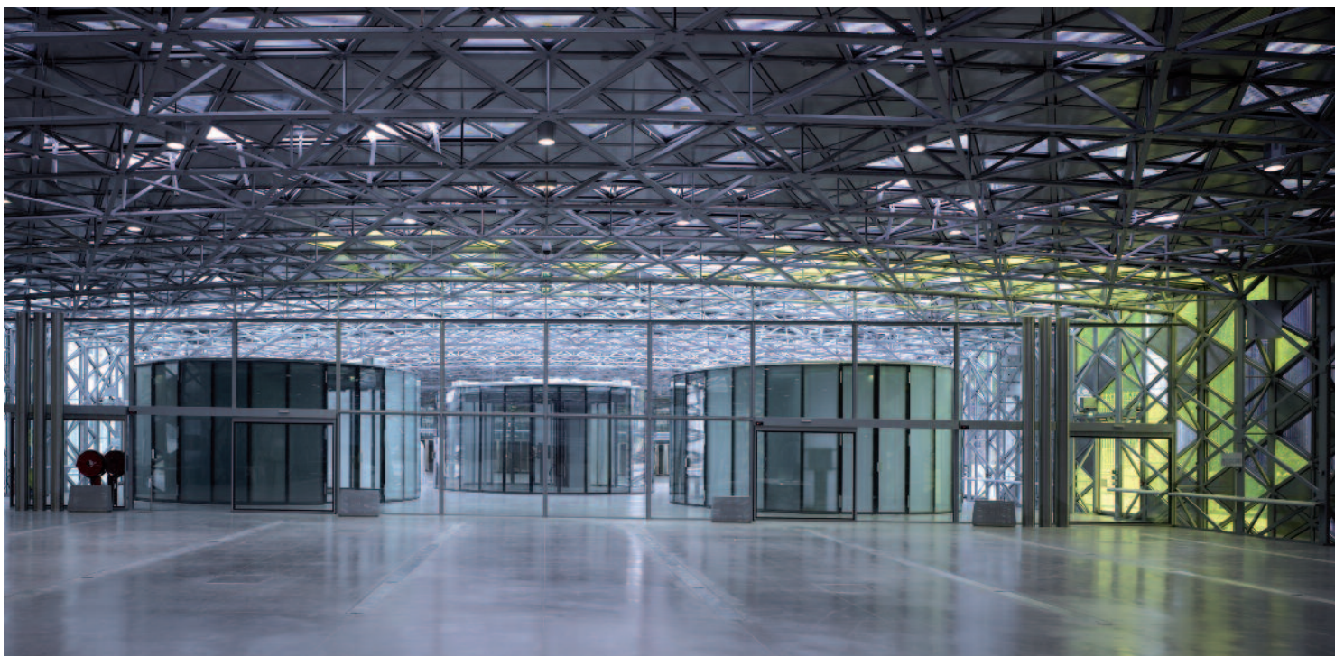
Bild 45: Die im Stahlbau verwendeten Schraubverbindungen ermöglichen eine leichte Demontage des Tragwerks, so dass der Stahl nach dem Nutzungsende des Gebäudes weiterverwendet oder recycelt werden kann. (Architekt: LIN Fin Gaipel + Giulia Andi, Berlin)
