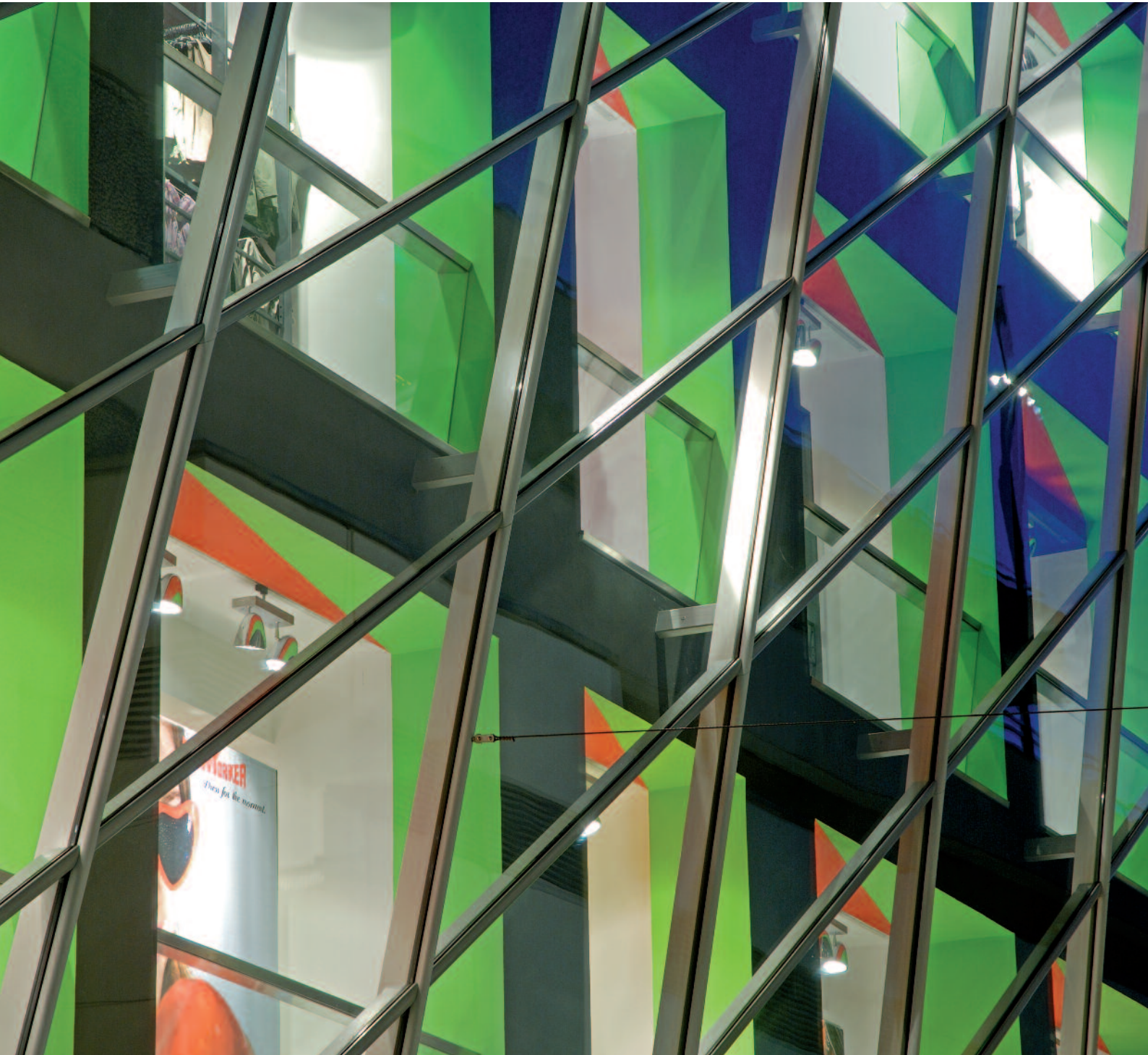
Bild 3: Die biegesteifen Steckverbindungen der vorgesetzten, filigranen Fassade erlauben eine schnelle Montage und verleihen der Fassade eine schlanke Optik. (Architekt: Karsten K. Krebs Architekten, Hannover)
