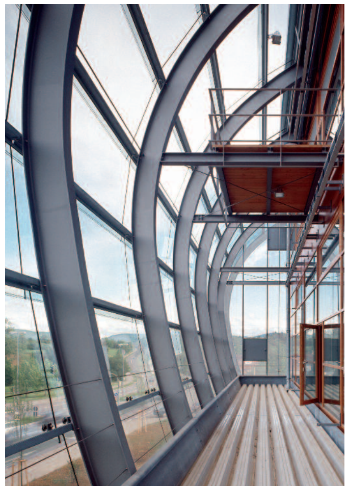
Bild 69: Korrosionsschutz: Für den Innenbereich wurde hier eine einfache Beschichtung gewählt. (Architekt: Wulf + Partner, Stuttgart)
