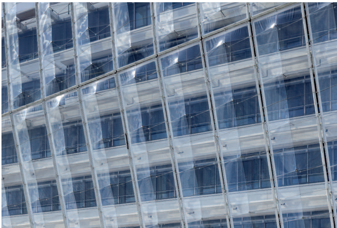
Bild 23: Die leichte Folien-Außenhaut schützt vor Wind, Wetter und Lärm. (Architekt: Behnisch Architekten, Stuttgart)
