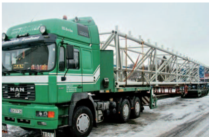
Bild 53: Just in Time – Anlieferung eines Stahlbauelementes.
