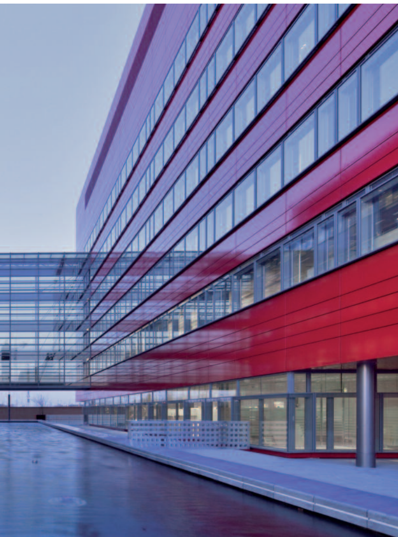
Bild 46: Bank Dexia in Luxemburg: Die Komplexität moderner Bürogebäude ist am besten mit einem integralen Planungsansatz zu meistern. (Architekt: VASCONI Associés Architecte, Paris)
