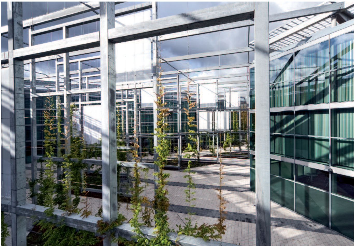
Bild 70: Korrosionsschutz: Für den Einsatz im Außenbereich wird oft Feuerverzinken bevorzugt. (Architekt: Murphy / Jahn, Berlin)
