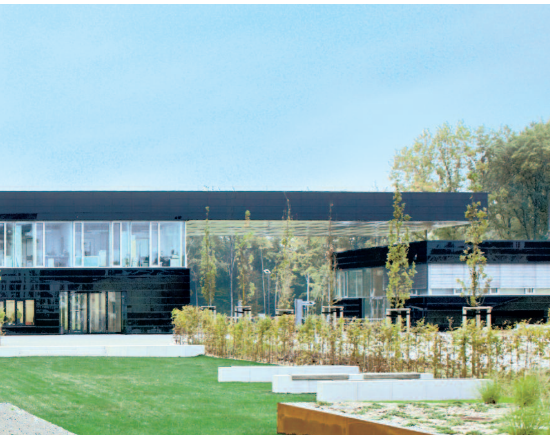
Bild 26: Forschungszentrum Dresden-Rossendorf: die Außenraumgestaltung ist ansprechend. (Architekt: Henn Architekten, München).
