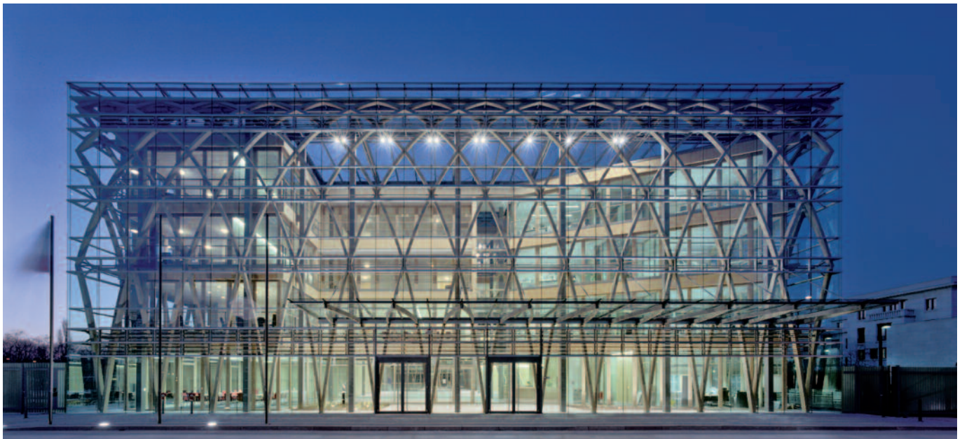
Bild 12: Die Landesvertretung NRW in Berlin ist eine schlanke Stahlkonstruktion mit Holzkassetten-Decken. (Architekt: Pezinka Pink Architekten, Düsseldorf)
