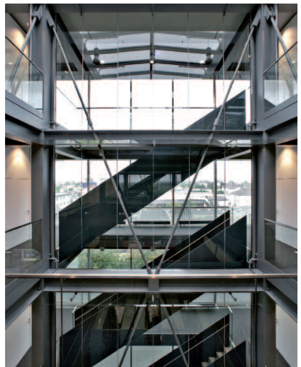
Bild 42: Ein gutes Brandschutzkonzept macht es möglich: sichtbarer Stahl bei Geschossbauten. (Architekt: Gerken Architekten + Ingenieure, Ulm)
