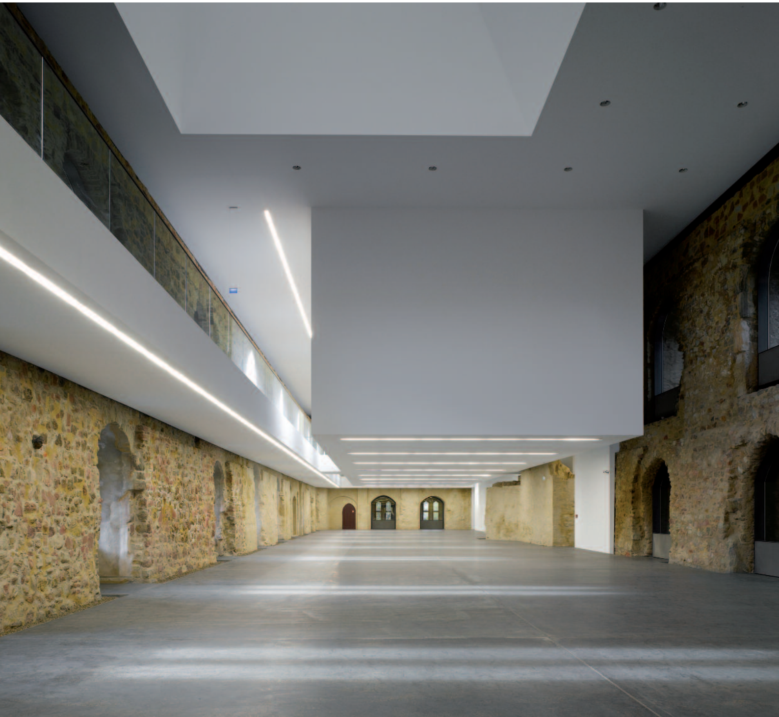
Bild 11: Bauen im Bestand beim Kunstmuseum Moritzburg: Dach und Einbauten scheinen zu schweben – tragend ist eine Stahlkonstruktion. (Architekt: Nieto Sobejano Arquitectos S. L., Berlin)
