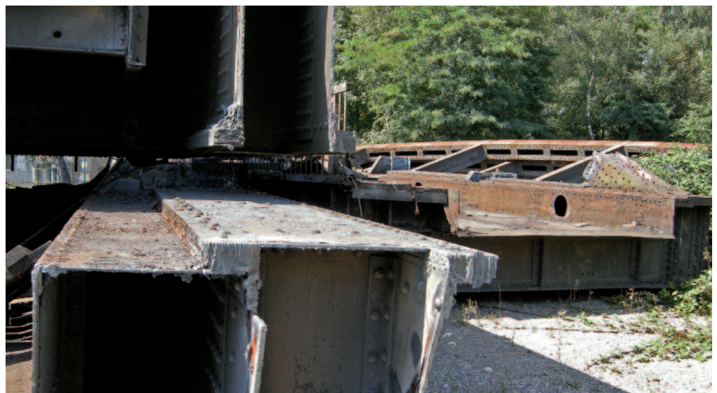
Bild 8: Die Stahlbrücke wird nach ihrem Lebensende zurückgebaut, der Stahl wird vollständig recycelt.
