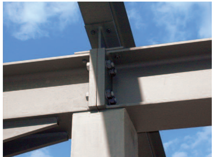
Bild 57: Stahlbaudetail: Schraubverbindungen sind lösbar.
