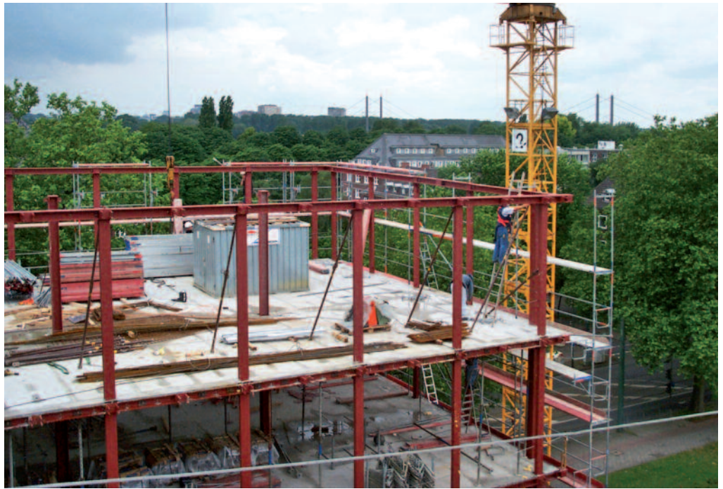
Bild 48: Präzise, sauber und aufgeräumt – Geschossbau mit vorgefertigten Stahlbauteilen (Architekt: Pezinka Pink Architekten, Düsseldorf)
