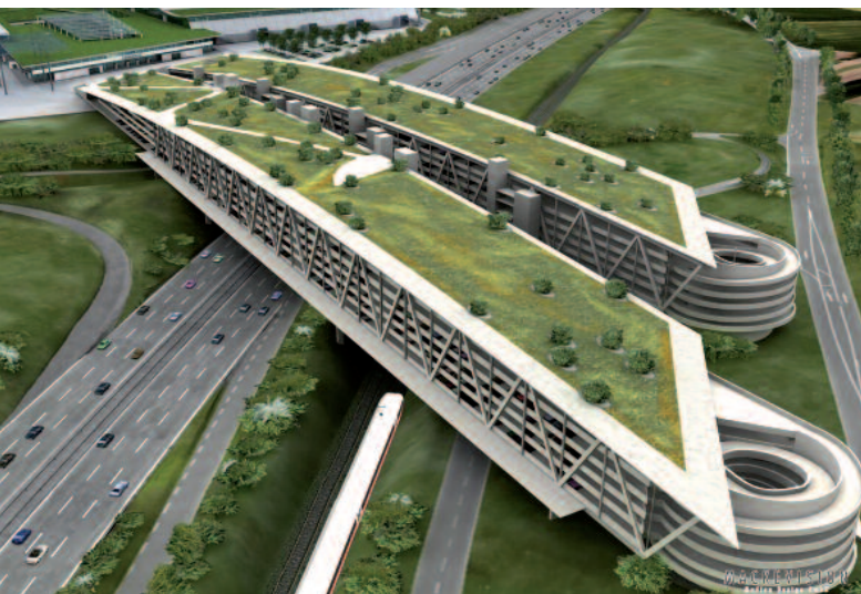
Bild 31: Das Parkhaus der Landesmesse Stuttgart ist gut in die Landschaft integriert. (Architekt: Wulf & Partner, Stuttgart)
