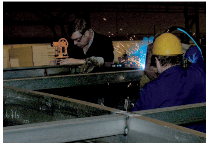
Bild 52: Stahlbaufertigung im Werk: Schweißen und Qualitätskontrolle laufen hier parallel.
