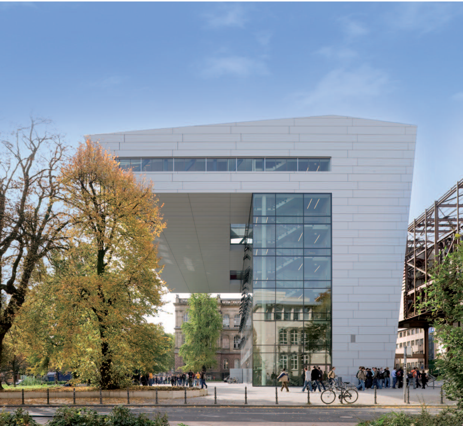
Bild 27: SuperC in Aachen: In der Pilotphase des DGNB-Gütesiegels wurde dieses Gebäude zertifiziert. (Architekt: Fritzer + Pape, Aachen)
