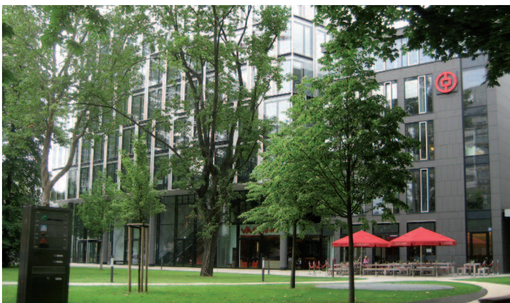
Bild 40: WestendDuo in Frankfurt: Das Café im Erdgeschoss ist öffentlich zugänglich. (Architekt: KSP Jürgen Engel Architekten, Frankfurt/Main)
