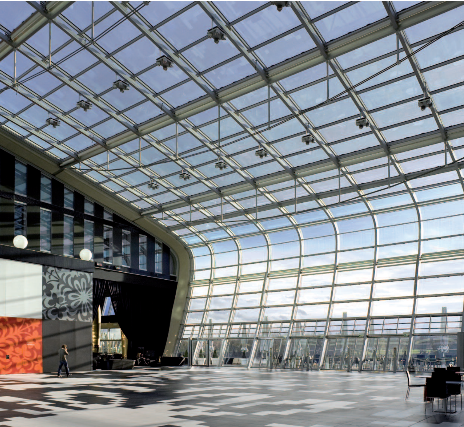
Bild 1: Kameha Grand Bonn: Die Fassadenprofile der Eingangshalle sind an die Geothermieanlage angeschlossen und tragen so zum angenehmen Raumklima bei. (Architekt: Karl-Heinz Schommer, Bonn)
