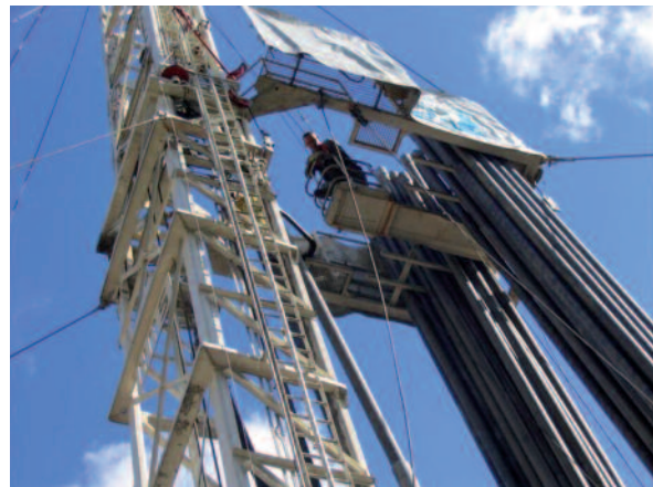
Bild 9: Bohranlage zur Nutzung der Geothermie
