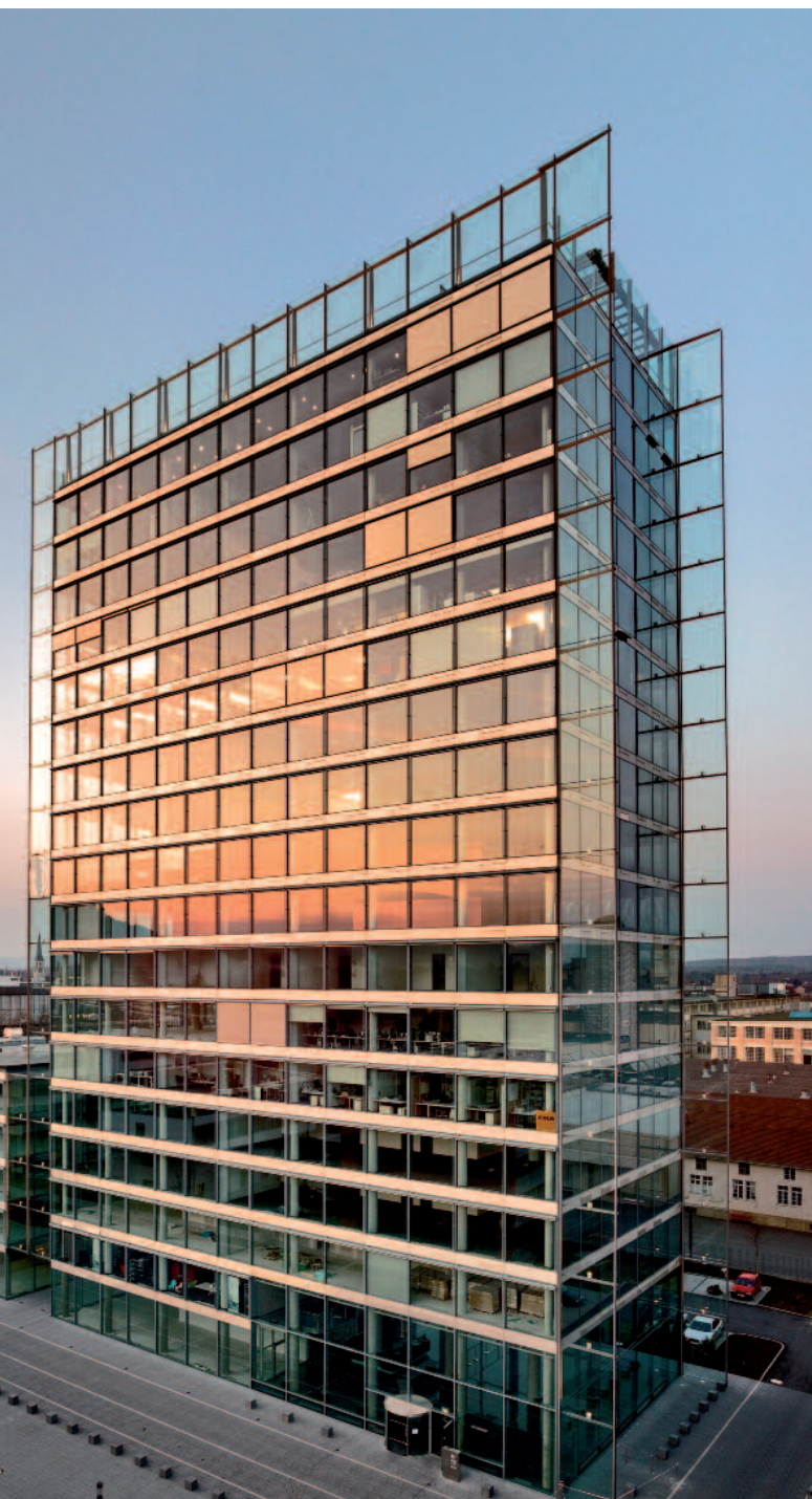
Bild 58: Außenliegender Sonnenschutz, individuell verstellbare Lüftungsöffnungen und Stahlbetondecken als Speichermedium sorgen für nur geringe Klimatisierungsanforderungen im Sommer und ermöglichen Wärmeeintrag im Winter. (Architekt: Murphy / Jahn, Berlin)
