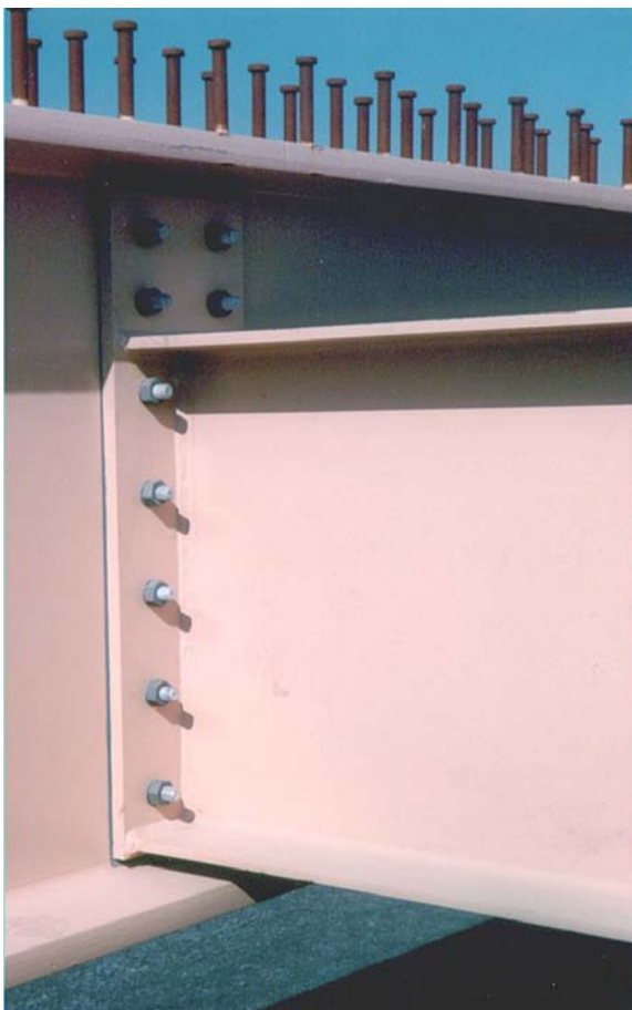
Bild 18: Detailausführung geschraubter Kopfplattenanschluss für den I-Querträger an den Hauptträger; links: Praxisbeispiel Montagezustand; rechts: verzinkungsgerechte Ausführung mit Durchflussöffnungen
