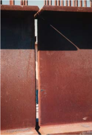
Bild 21: Schweißnahtvorbereitung für einen geschweißten Stumpfstoß von warmgewalzten Breitflanschträgern für eine Verbundbrücke
