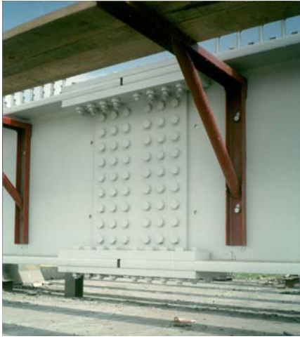
Bild 24: Geschraubter Laschenstoß der Hauptträger einer Verbundbrücke in Istanbul, Türkei
