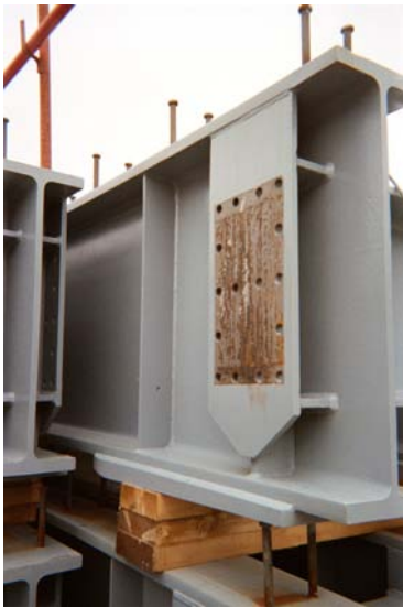
Bild 8: Detailausführung einer T-Rippe für den geschraubten Anschluss des I-Querträgers; links: Praxisbeispiel Montage; rechts: verzinkungsgerechte Ausführung mit Durchflussöffnungen
