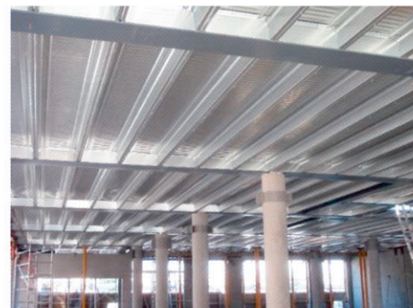
Bild 6: Slim-Floor Träger in Verbundbauweise mit Cofraplus 220 Decke
