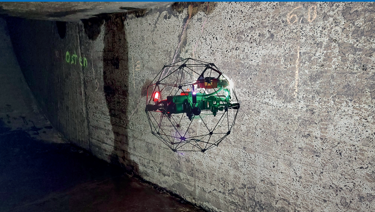
Drohneinsatz im Längslauf der Schleuse Sülfeld
