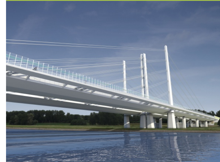
Rheinbrücke Duisburg-Neuenkamp © DEGES und Keipke Architekten
