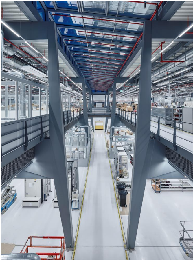
Ingenieurpreis des Deutschen Stahlbaues 2017, Kategorie Hochbau: Sartorius - Neubau einer Produktionshalle für Laborinstrumente in Göttingen, Martin Speth, DREWES + SPETH und Christian Rathmann, Bünemann & Collegen © Clemens Ortmeier
