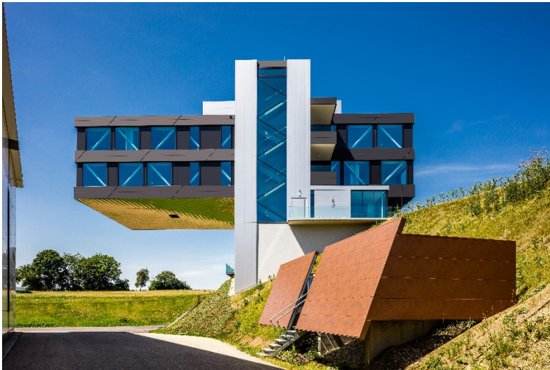
Projekt: Kunden- und Kompetenzzentrum DOMICO, Vöcklamarkt/Österreich Vortragstitel: Modern und zeitlos | Fassaden aus Stahl“ Referent: Volkmar Burgstaller Büro: Atelier Volkmar Burgstaller ZT © Martin Steinkellner
